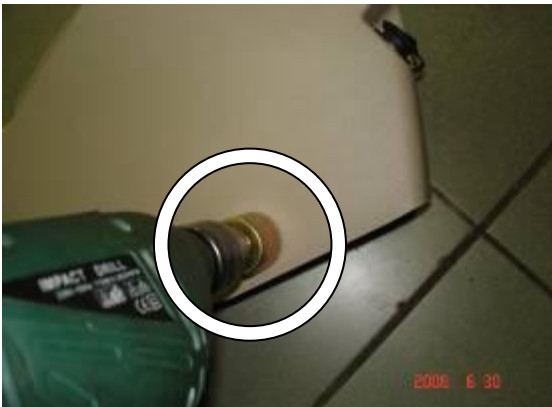
Просверлить и расширить отверстие
